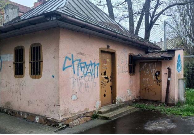
Zdjęcie 5 Zdjęcia z terenu Chorzów Stary
