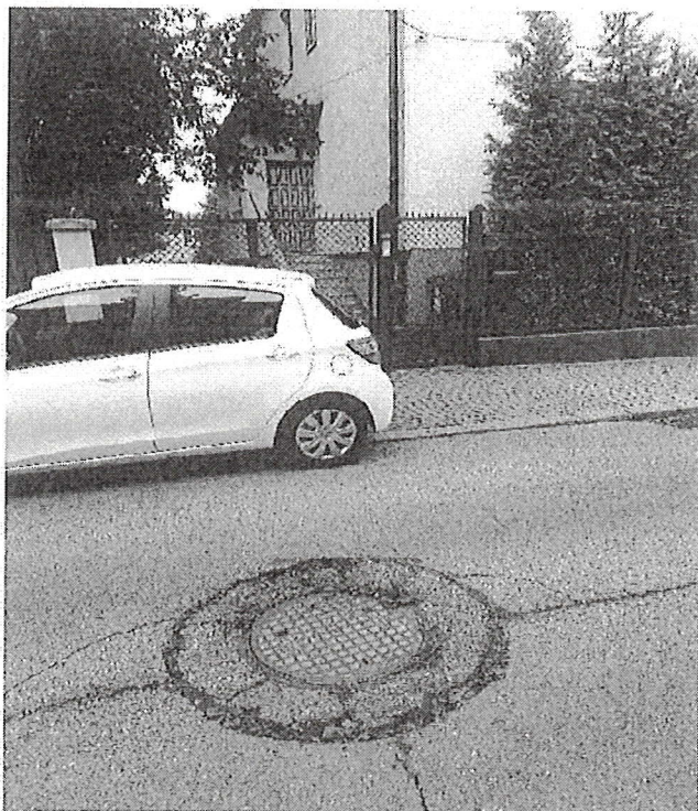
Klawiszujący wjazd przy numerze 23 – wymiana wjazdu
